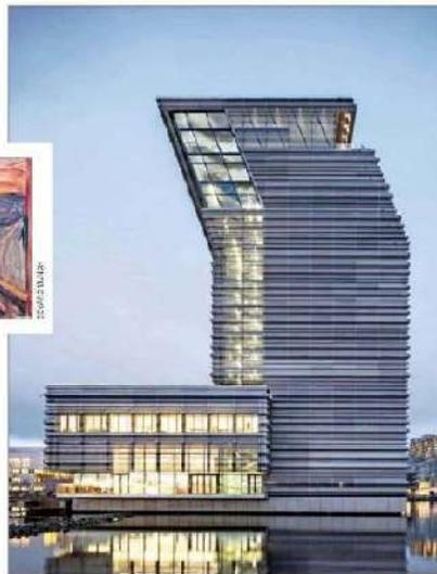
El edificio destaca por su gran altura, los materiales reciclados que lo revisten y la inclinación de 45° de sus últimos pisos hacia el fondo marino.
